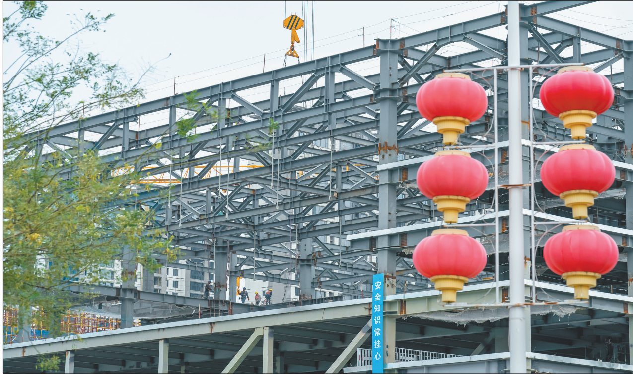
10月5日,施工人员在运城市民服务中心项目现场加紧作业。
