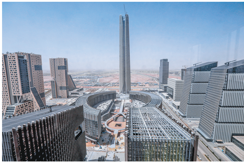
这是在埃及开罗以东拍摄的建设中的新行政首都中央商务区(9月11日报)。新华社发(艾哈迈德·戈马 摄)
