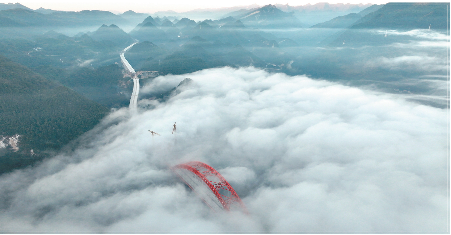
◀这是11月20日拍摄的建设中的涇水河特大桥（无人机照片）。
