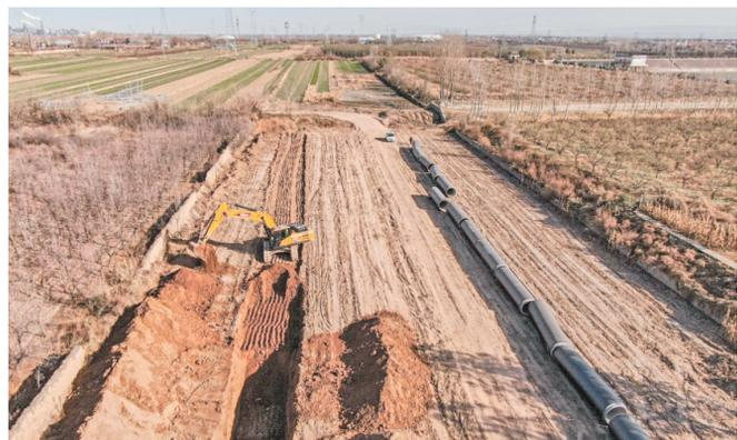
近日拍摄的离门口灌区“十四五”大型灌区续建配套与现代化改造项目输水管道工程稷山县西社镇灌区施工现场。该工程在原二级干渠支口的基础上,增加出入口,为离门口引黄水务集团稷山、新绛灌区提供充足水源和供水保障,进一步提升黄河水资源供给保障能力,促进当地农业增产增收。
