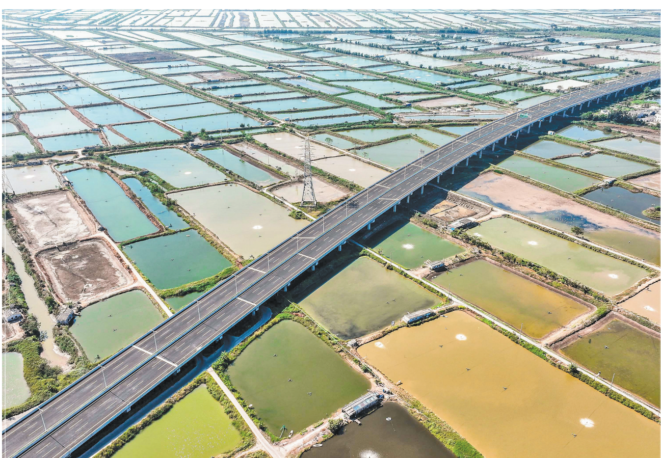
鹤港高速南水互通引桥跨越一片水产养殖区(12月8日报,无人机照片)。 由中铁十一局承建的珠海鹤洲至高栏港高速公路二期工程即将于12月9日零时通车运营。全长34.5公里的鹤港高速东连港澳大桥西延线,西接黄茅海跨海通道,共同组成粤港澳大湾区基础设施“硬联通”交通主干线之一。
