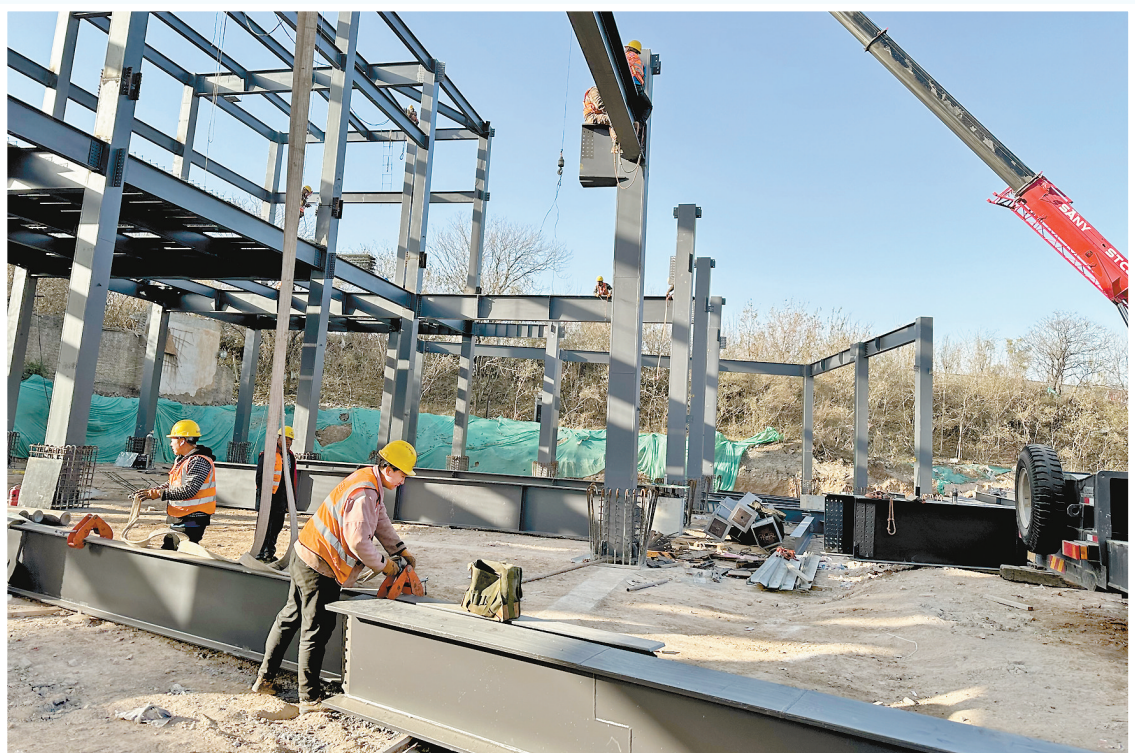
建设中的盐湖水泵专业镇综合服务中心。本报记者 朱 姝 摄
