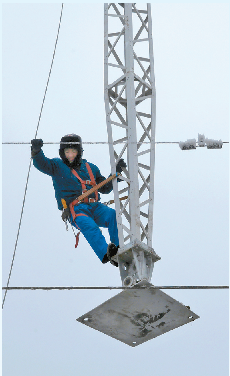
▲12月14日，在闻喜县茨庙村金石线抢修现场，电力工人在吊装应急铁塔。 本报记者 金玉敏 摄
