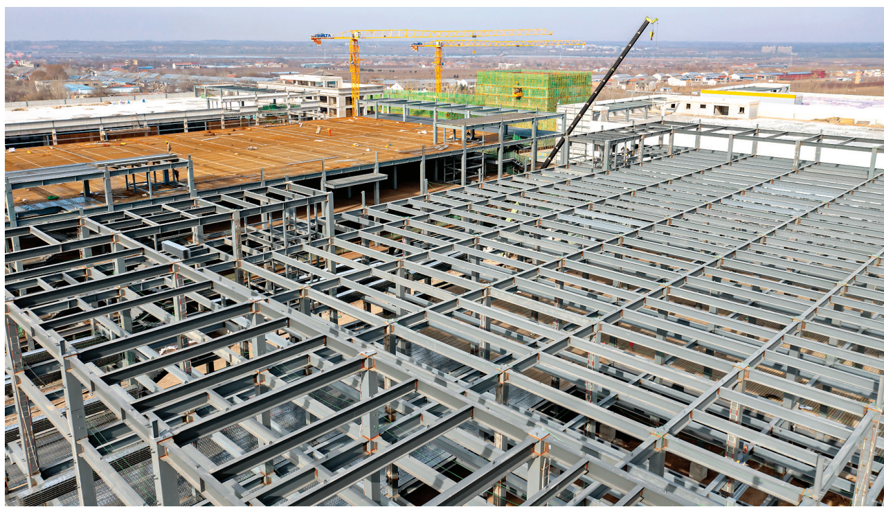
寒冬时节,永济市光电产业园项目施工现场,建设单位加班加点,战严寒、赶进度,确保项目如期完工。该项目建成后,将集聚更多顶尖光电产业链企业和人才,带动上下游产业发展,为当地打造光电产业集群、构建现代产业矩阵提供强劲动力。
