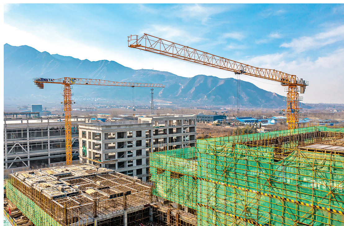
建设中的永济光电产业园项目。本报记者 闫鑫摄
