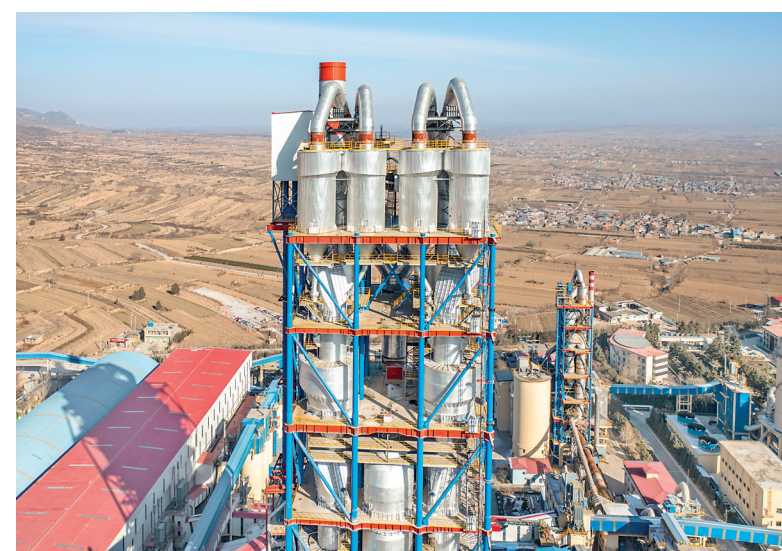
威顿水泥集团数字化智能化绿色工厂技术改造项目现场。
