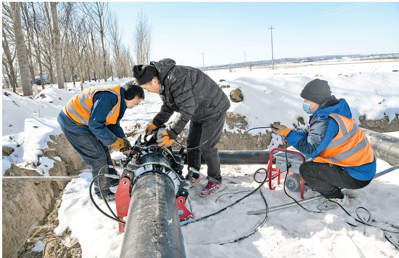
1月23日,技术人员在闻喜县裴社镇裴社村高标准农田建设项目工地安装管道。闻喜县高标准农田建设项目于2023年10月开工,总投资3000万元,涉及裴社镇裴社村、小王沟村、王宋村和新庄村,建设内容包括小浪底引黄灌溉配套工程、田间道路硬化工程和农田输配电工程,其目标是提升改造高标准农田两万余亩。 特约摄影 温徐旺 摄
