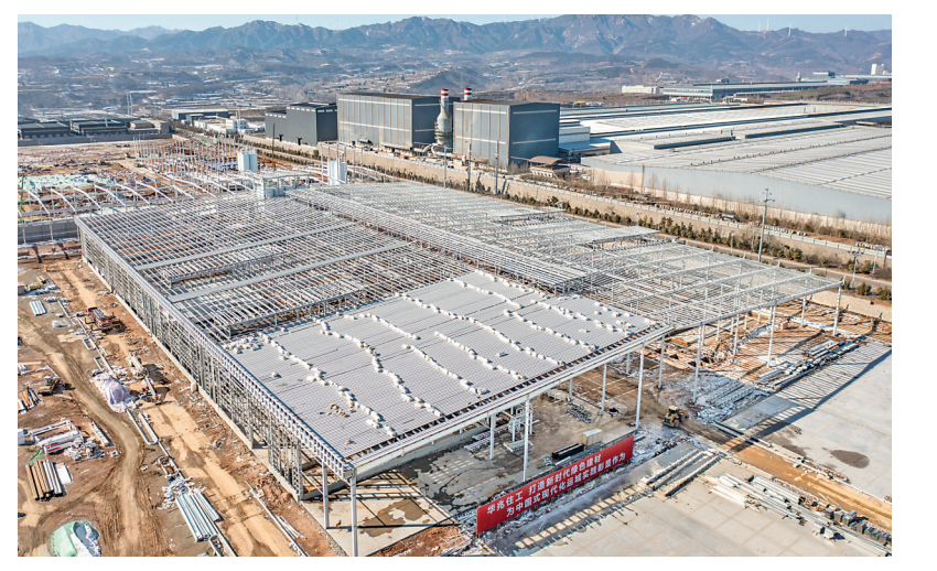
华兆住工ALC装配式建筑新材料项目建设现场。 本报记者 茹雅 摄
