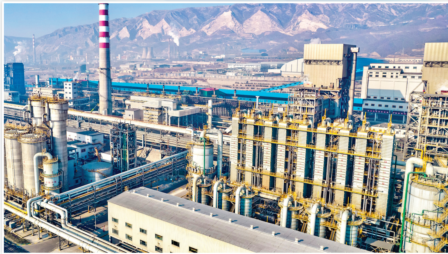
上 图:山西安昆新能源有限公司采用国内先进的环保设备和节能减排技术,实现“废水、废渣、废气”零排放。
