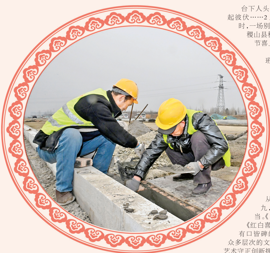
2月18日,在安邑西路北延(引黄渠—迎宾街)项目建设现场,工人在安装雨水收集口。
