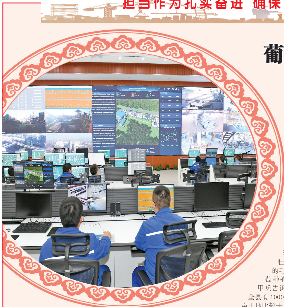
2月26日，位于稷山经济技术开发区的山西东方资源发展集团有限公司106万吨捣固焦化项目中央控制室，工人在监测企业焦化设备运行情况。该公司创新实施数字化、智能化改造，借助现代化科技信息手段运用和平台搭建，赋能传统产业转型升级，实现炼焦生产全自动、生产过程数字化管控。 特约摄影 栗卢建 摄
