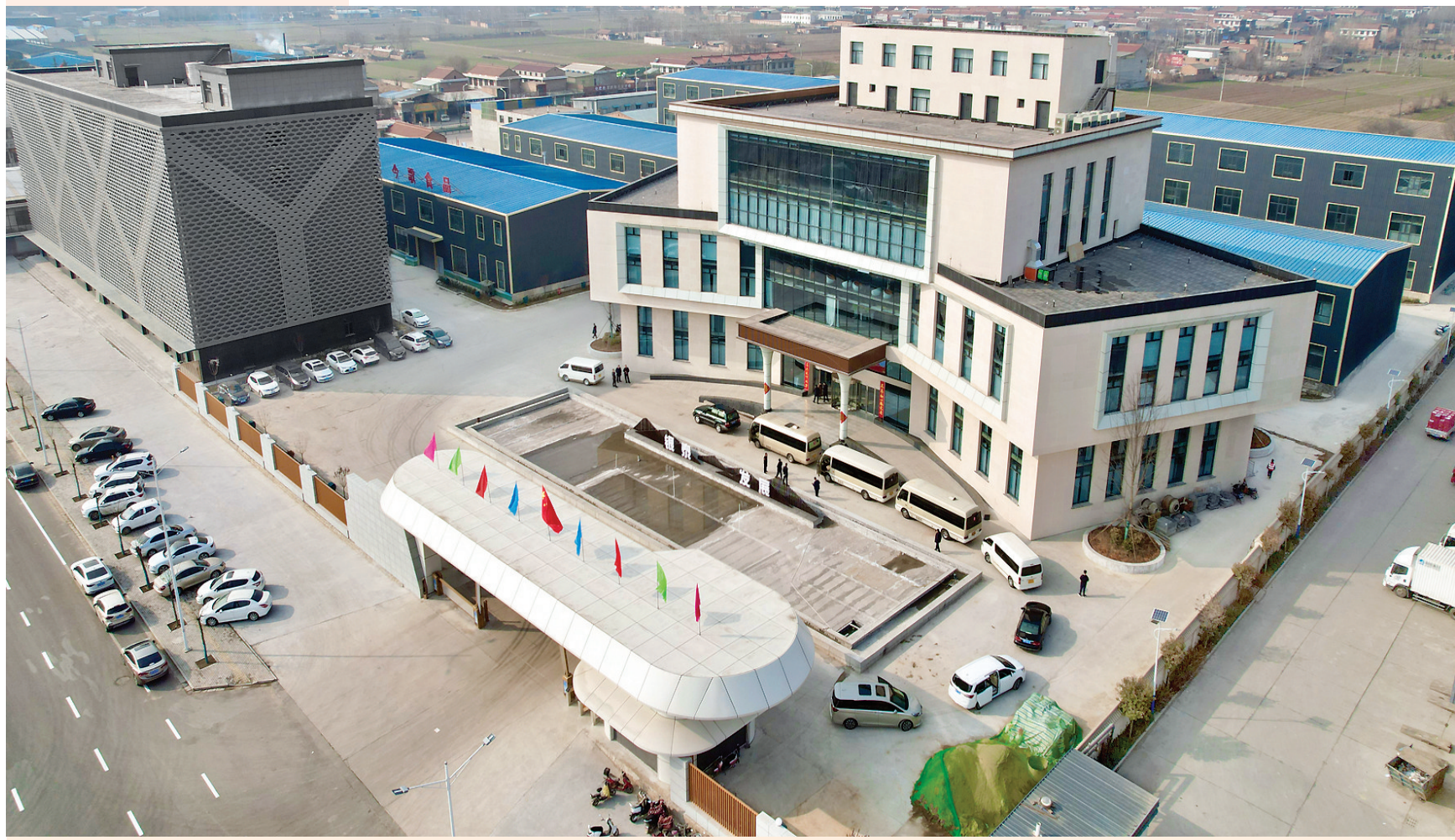
新绛县 山西今歌食品有限公司农副产品深加工及物流产业园建设项目。
