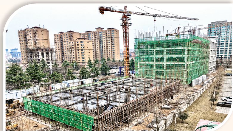
平陆县 中达商贸中心建设项目。
