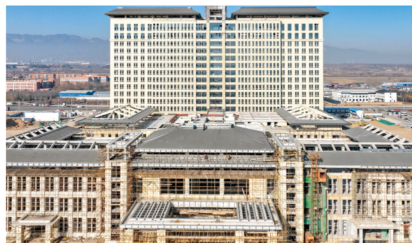
正在建设的稷山县人民医院新院。
