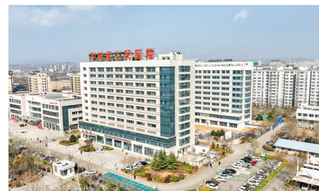
平陆县人民医院内科住院楼建设项目现场。
