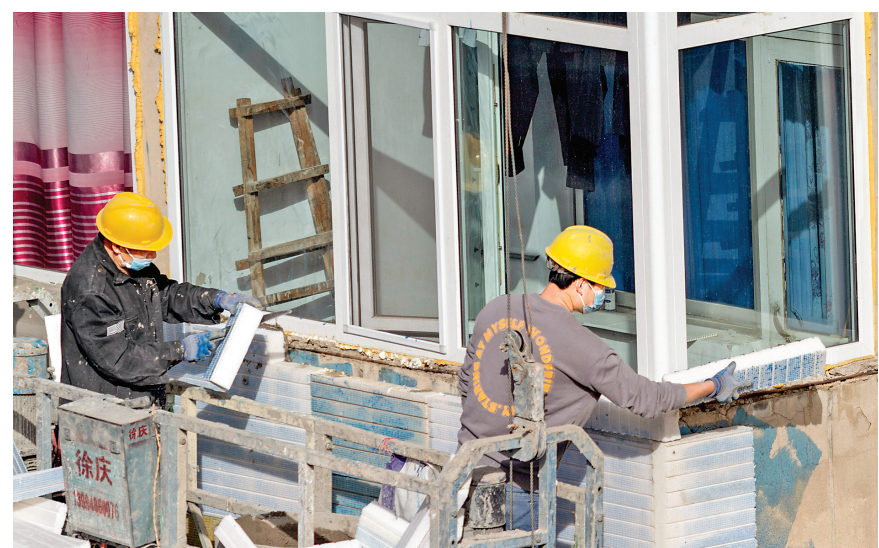
3月19日,工人在盐湖区一小区实施外墙改造作业。去年以来,我市老城区脏乱差棚户区住房改造新开工985套,今年全市城镇保障性安居工程建设将继续稳步推进。
