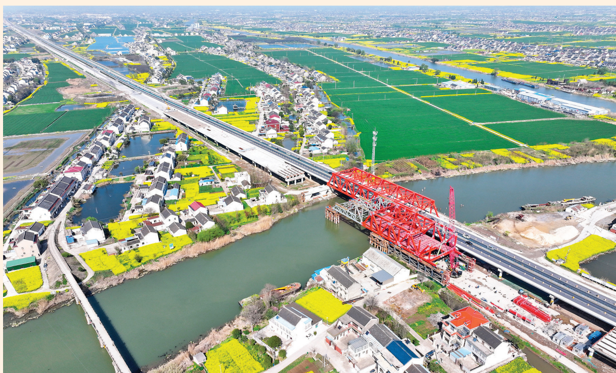
这是3月29日拍摄的沪陕高速公路平潮至广陵段扩建工程施工现场(无人机照片)。沪陕高速公路平潮至广陵段扩建工程起自江苏南通平湖北枢纽，止于泰州广陵枢纽东侧，全长约48.966公里，计划2024年年底建成。目前，南通段路面基层已全部完成，正在有序推进沥青面层施工；泰州段正在稳步开展桥梁工程、主桥钢桁梁拼装等作业。
