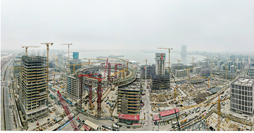
空中俯瞰建设中的上海临港新片区滴水湖金融湾项目(2024年1月18日摄,无人机全景照片)。新华社记者 方喆 摄
