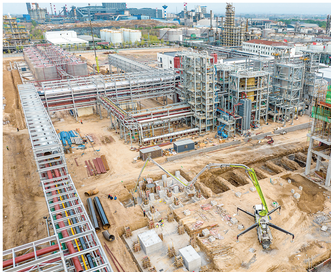
4月17日,工人在山西永东化工股份有限公司煤焦油精细加工及特种炭黑综合利用项目建设工地加紧施工。该项目总投资2.9亿余元,建成投产
