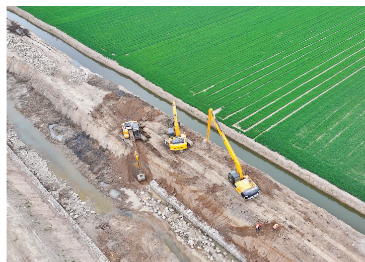
四月二十一日，在涑水河永济段河道治理工程现场，工人在加紧施工。近年来，永济市坚持防洪与生态并重，大力实施河道治理工程，着力打造河畅水清堤固岸绿的美丽家园。李向东 摄
