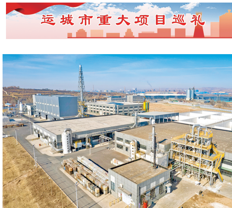
运城润泰厂区鸟瞰。
