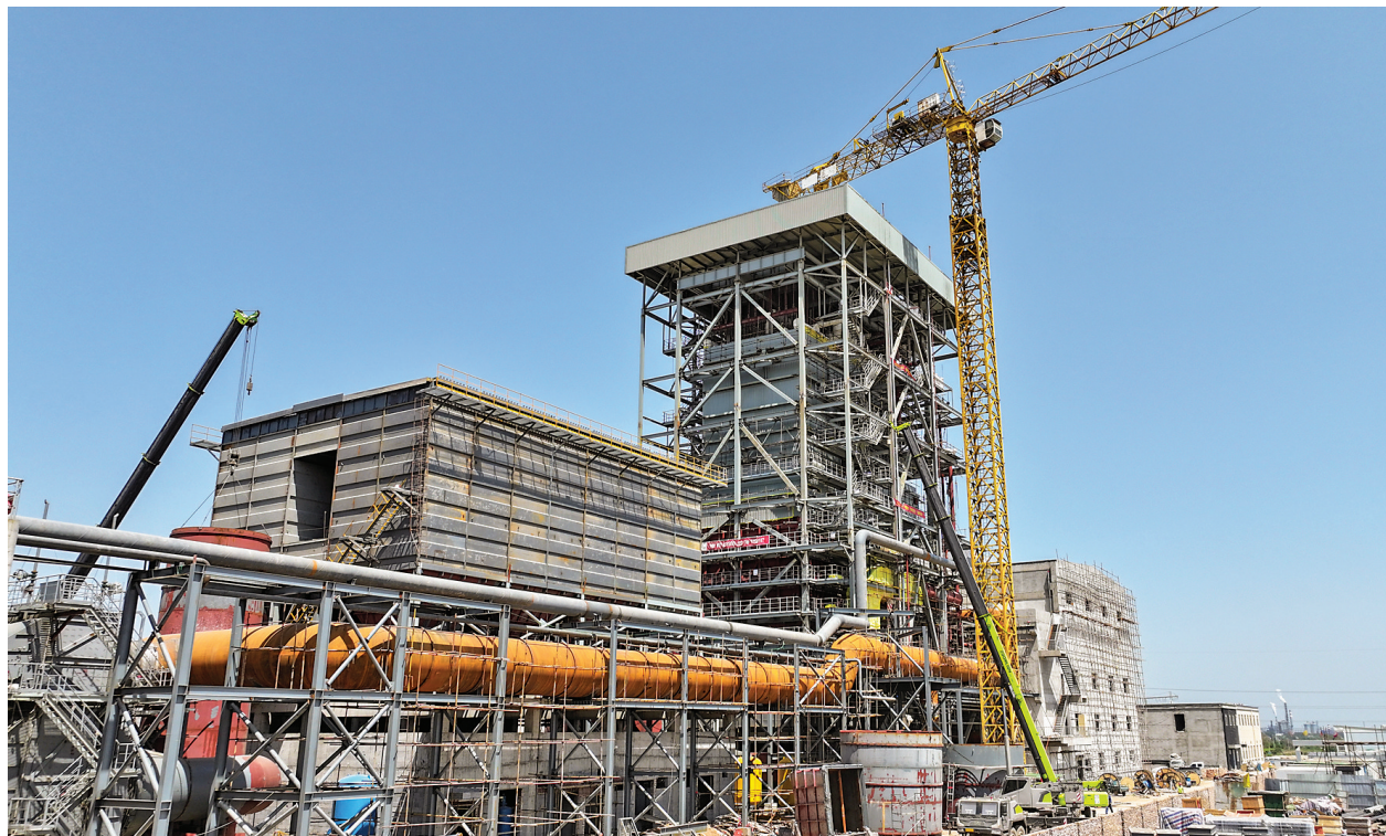
4月26日，位于稷山经济技术开发区的山西东方资源发展集团有限公司135MW超超临界煤气综合利用分布式发电项目在加紧建设中。今年以来，稷山县聚焦项目建设，持续扩大有效投资，千方百计找项目、挖资源、拓市场，全力推进工业转型，全年共谋划实施159个重点项目，总投资达254.2亿元。 特约摄影 栗卢建 摄
