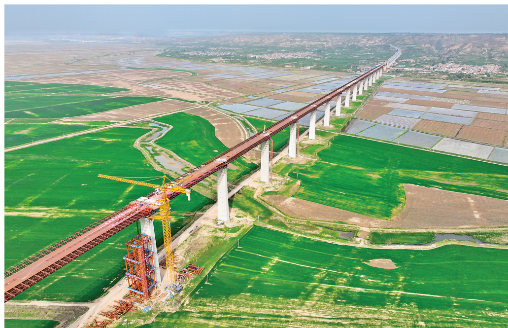
建设中的临猗黄河大桥。 特约摄影 张怀心 摄
