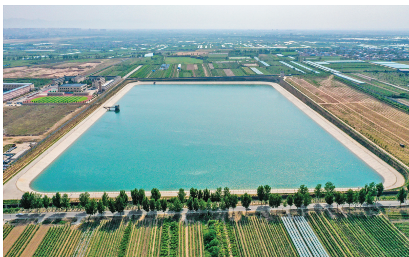
已经建成的盐湖区调蓄库项目(一期)。 本报记者 金玉敏 摄
