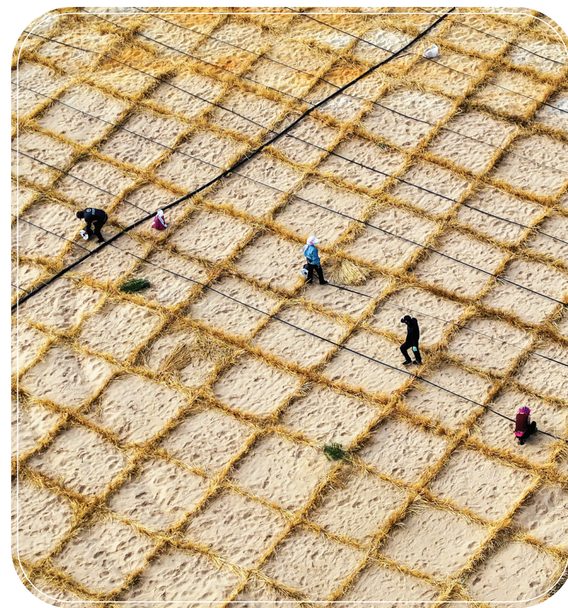
在赤峰市翁牛特旗巴彥呼文嘎查其白线防沙治沙项目区,治沙工人在道路两侧拉滴灌带,以提高草方格中的植物成活率(无人机照片,5月16日报)。
