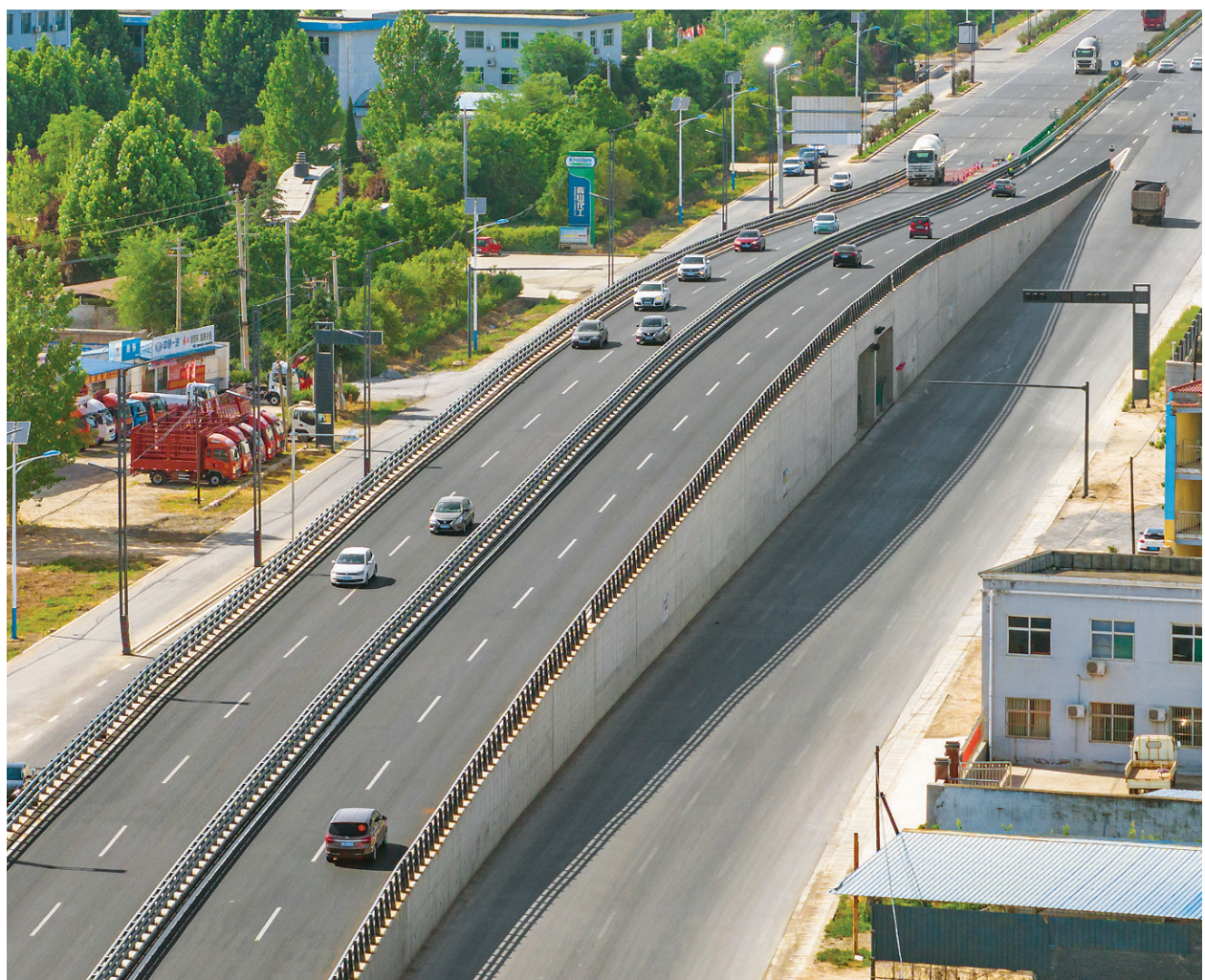
5月21日拍摄的209国道临猗县杨家庄路口上跨桥梁。据了解，209国道杨家庄路口及楚侯街路口两座主线上跨桥梁，目前已顺利通车。209国道快速化改造作为
