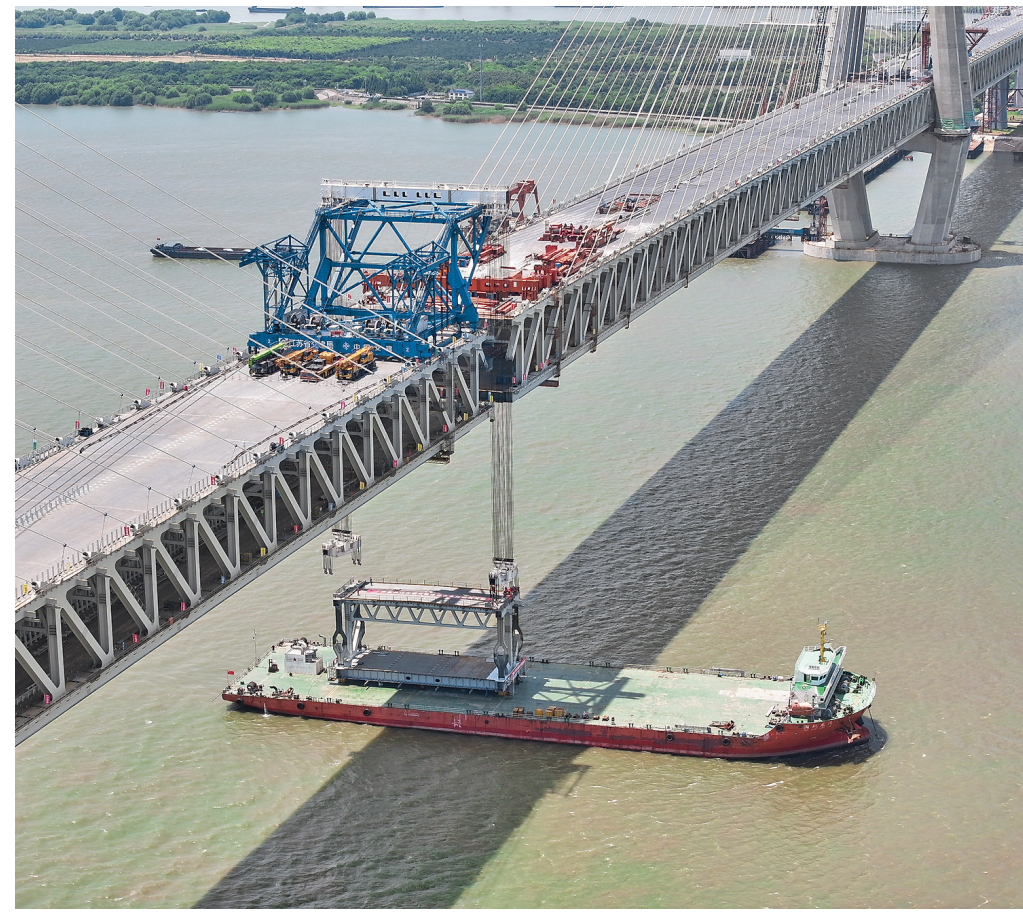
5月29日,常泰长江大桥主航道桥合龙段钢桁梁准备吊装(无人机照片)。当日,常泰长江大桥主航道桥最后一节钢桁梁——合龙段钢桁梁顺利吊装到位,拉开主桥合龙的序幕,预计6月上旬完成合龙,实现全桥贯通。常泰长江大桥连接江苏省的常州市与泰州市,是一座集高速公路、城际铁路、普通公路于一体的过江通道。新华社记者 季春鹏 摄
