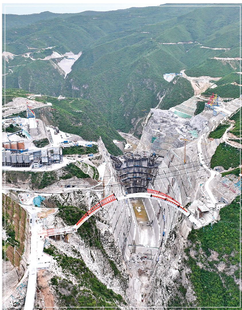
这是5月31日拍摄的陕西东庄水利枢纽施工现场(无人机照片)。当日，在中铁二十局集团承建的陕西东庄水利枢纽泾河大桥施工现场，约120吨的全桥副拱最重节段吊装成功，为后续建设奠定良好基础。目前，各参建单位严格把控施工节点计划，稳步推进项目建设。东庄水利枢纽位于陕西省咸阳市泾河峡谷，工程建成后将成为陕西省库容最大、坝高最高的水利工程。
