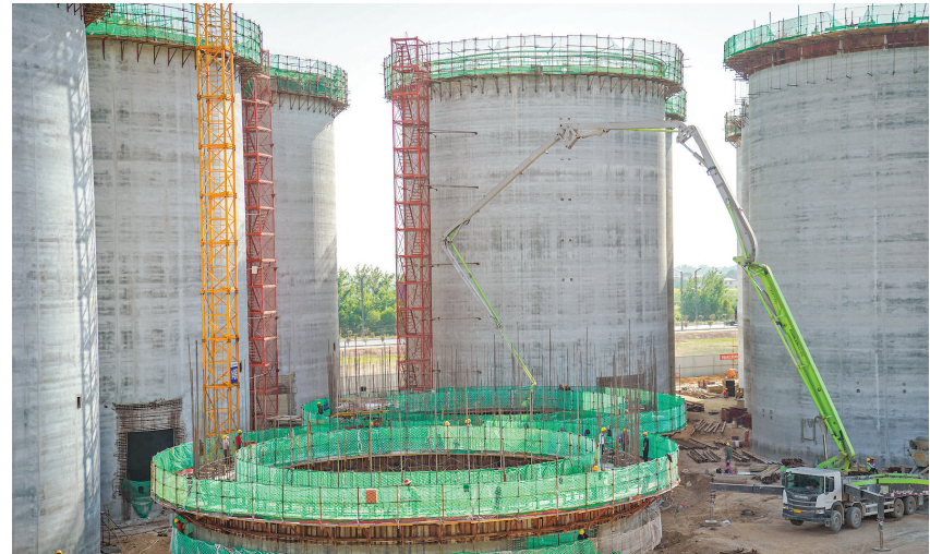
近日,位于临猗县的运城地方粮食战略储备库有限责任公司总仓仓容建设项目在紧张施工中。据了解,该项目占地约80亩,总投资30225.7万元。项目建成后,在完成地方粮食储备任务的同时,可充分发挥救灾应急作用,对于粮食保供稳价具有重要意义。
