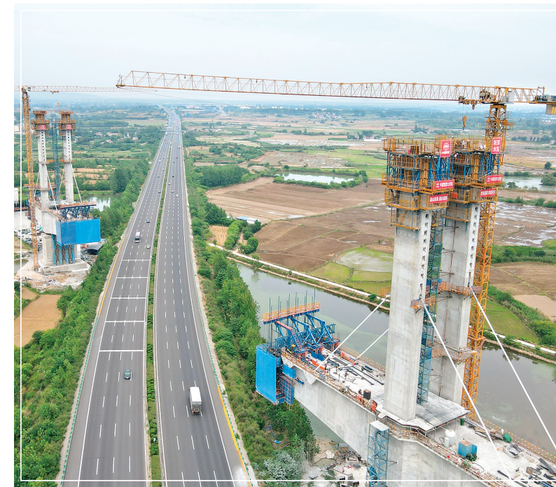
这是新建沪宁合高铁跨沪陕高速公路大桥主塔塔柱封顶施工现场(6月18日摄,无人机照片)。
