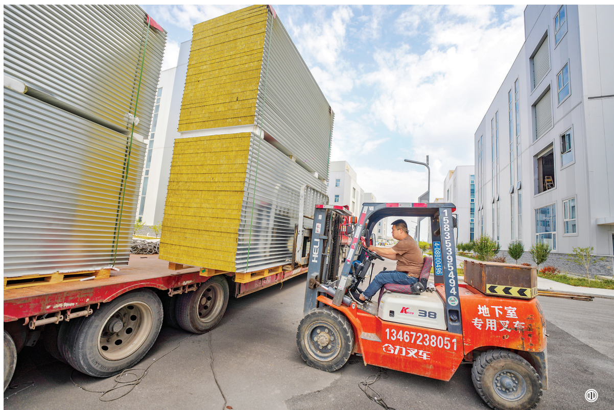
图① 晋陕豫黄河三角科技创新产业园内工人正在装卸货物。 图② 力达纸业新项目实施现场。 图③ 力达纸业新车间内技术人员在调试设备。 本报记者 陈方斌 摄
