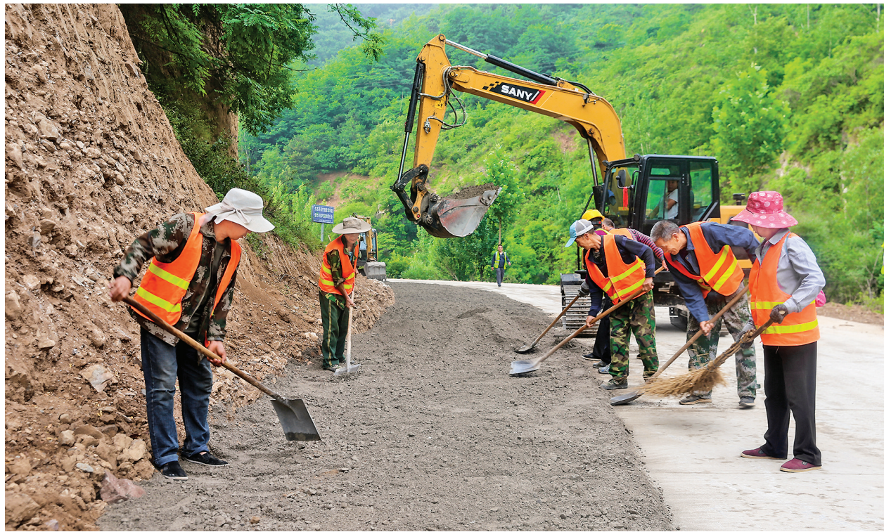
近日,夏县泗交镇圪马沟村通向架桑漂流景区的山间公路拓宽改造工程加紧施工。圪马沟村通向架桑
