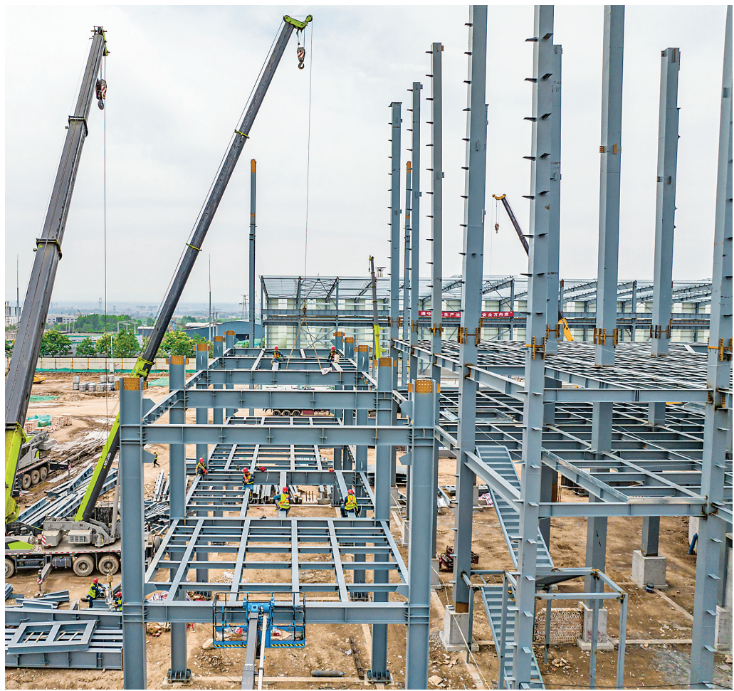
山西东方资源发展集团东耀精密材料有限公司二期工程建设有序推进。
