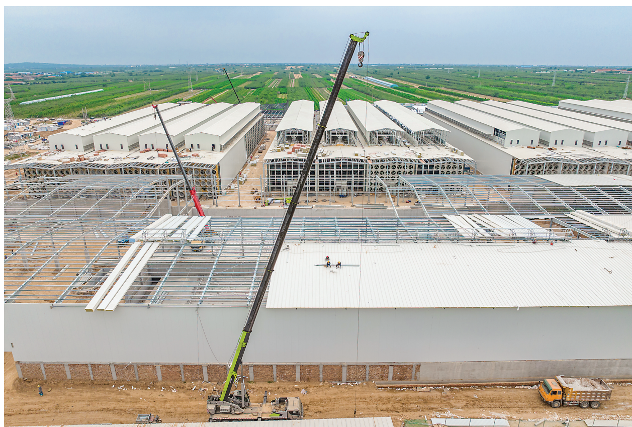
7月4日，位于临猗县北平乡的山西晋龙养殖股份有限公司临猗分公司年存栏600万只蛋鸡养殖项目加紧建设中。该项目是全市“1311”重大工程项目，占地577.7亩，总投资8.5亿元。项目建成投产后，将成为国内单体最大、标准最高、技术最优的标准化蛋鸡养殖基地，可实现年产值10亿元，有力助推乡村振兴和镇域经济发展。
