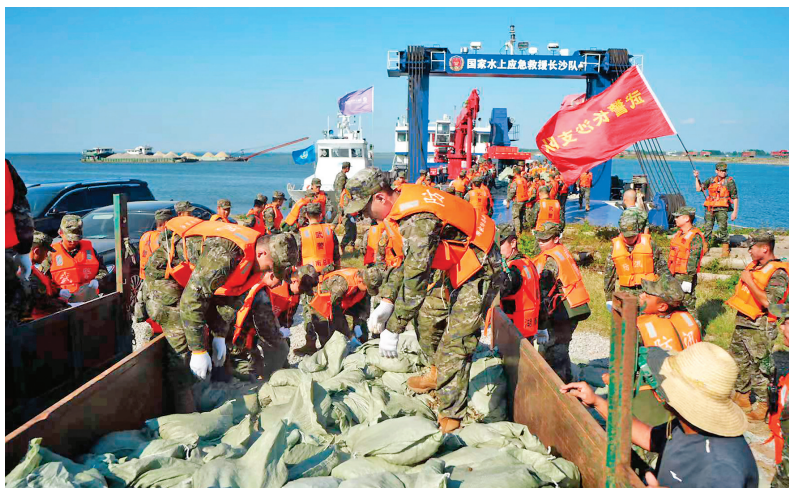
7 月 6 日，武警湖南总队官兵在湖南省岳阳市华容县团洲垸受灾现场第二道防线搬运沙袋加固堤坝。
