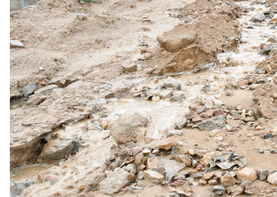
7月5日，河津经济技术开发区化工园基础设施建设项目企业供水管道施工现场，山西路桥建设集团的工作人员冒雨巡查，并及时修整水路，确保汛期安全。
