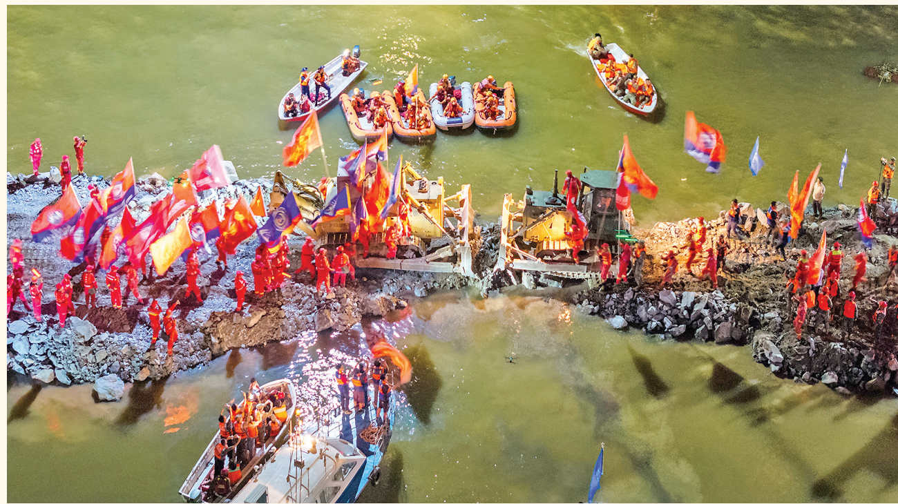
这是7月8日晚拍摄的团洲垸洞庭湖大堤决口封堵现场(无人机照片)。7月8日22时31分,记者在湖南华容县团洲垸洞庭湖大堤决口封堵现场看到,团洲垸洞庭湖大堤决口完成封堵。新华社记者 陈思汗 摄
