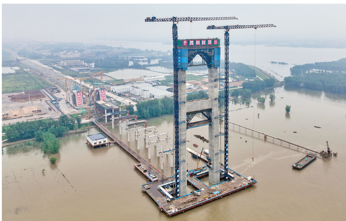
7月14日拍摄的燕矶长江大桥主塔施工现场(无人机照片)。
