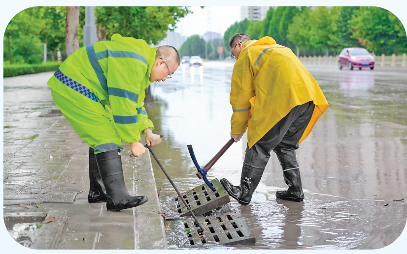
市城市管理局排水服务中心工作人员在疏通排水井。本报记者 闫鑫 摄
