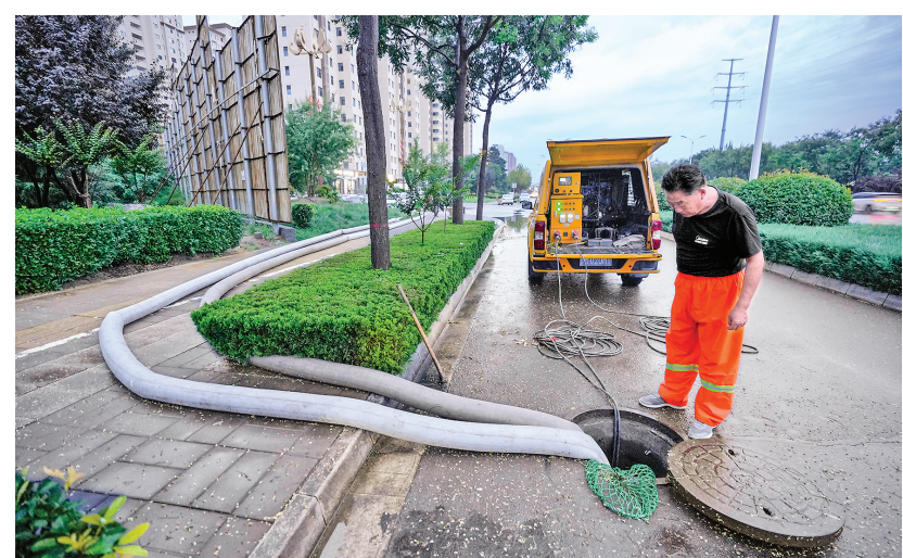
8月3日,市城市管理局排水服务中心工作人员在中心城区河东东街芦子沟高速桥西路段查看排水情况。面对新一轮雷雨天气,该局出
