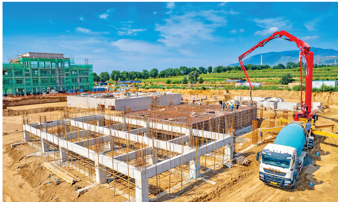
8月11日，万荣县皇甫工业园污水处理项目建设工地，工人在加紧施工。据了解，该项目是万荣县重点民生工程，总投资5200万余元。项目建成后 will 促进水质提升和环境改善，对工业园区的发展具有很强的带动作用。本报记者 常奇 摄
