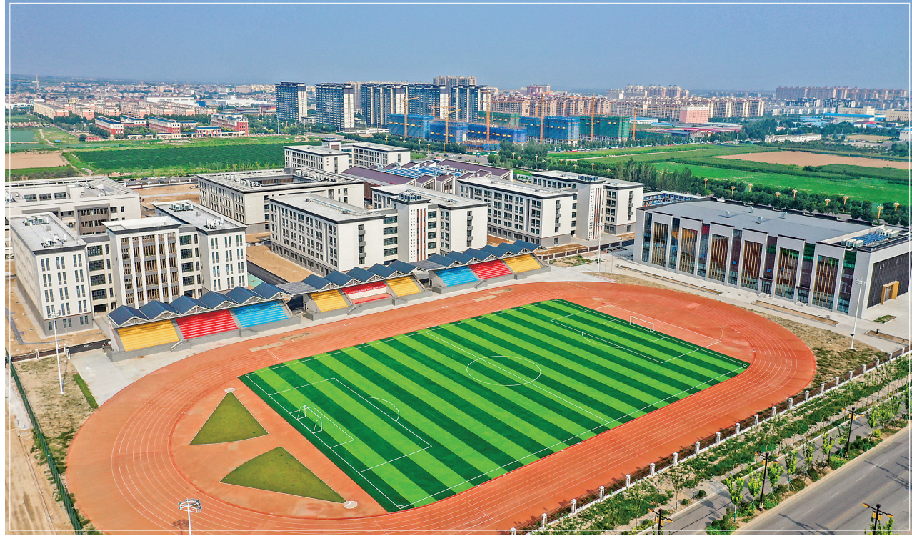
8月24日，万荣县万荣中学迁建项目现场，施工方抓紧完善收尾工程，确保9月初新迁学校开学。万荣中学新校区总面积200多亩，新建总面积为
