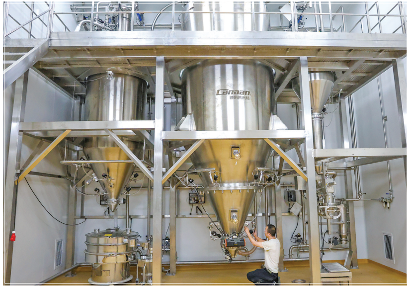
山西华康药业有限公司新建现代化前处理车间，技术人员加紧对新安装的联机生产设备进行调试、准备投产（8月24日摄）。为推进中药生产高质量发展，该公司总投资7800多万元，新建总建筑
