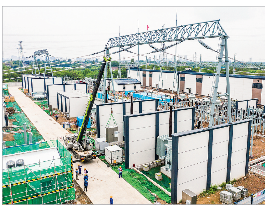
9月3日,空中俯瞰500千伏长兴变电站建设施工现场(无人机照片)。位于浙江省湖州市长兴县画溪街道的长兴500千伏输电工程是浙江省重点建设项目,总投资14.38亿元,将建成浙北地区重要的清洁能源消纳和源网荷储互动应用枢纽变电站,变电容量200万千瓦安,年供电电量可达70亿千瓦时。新华社记者 徐昱 摄
