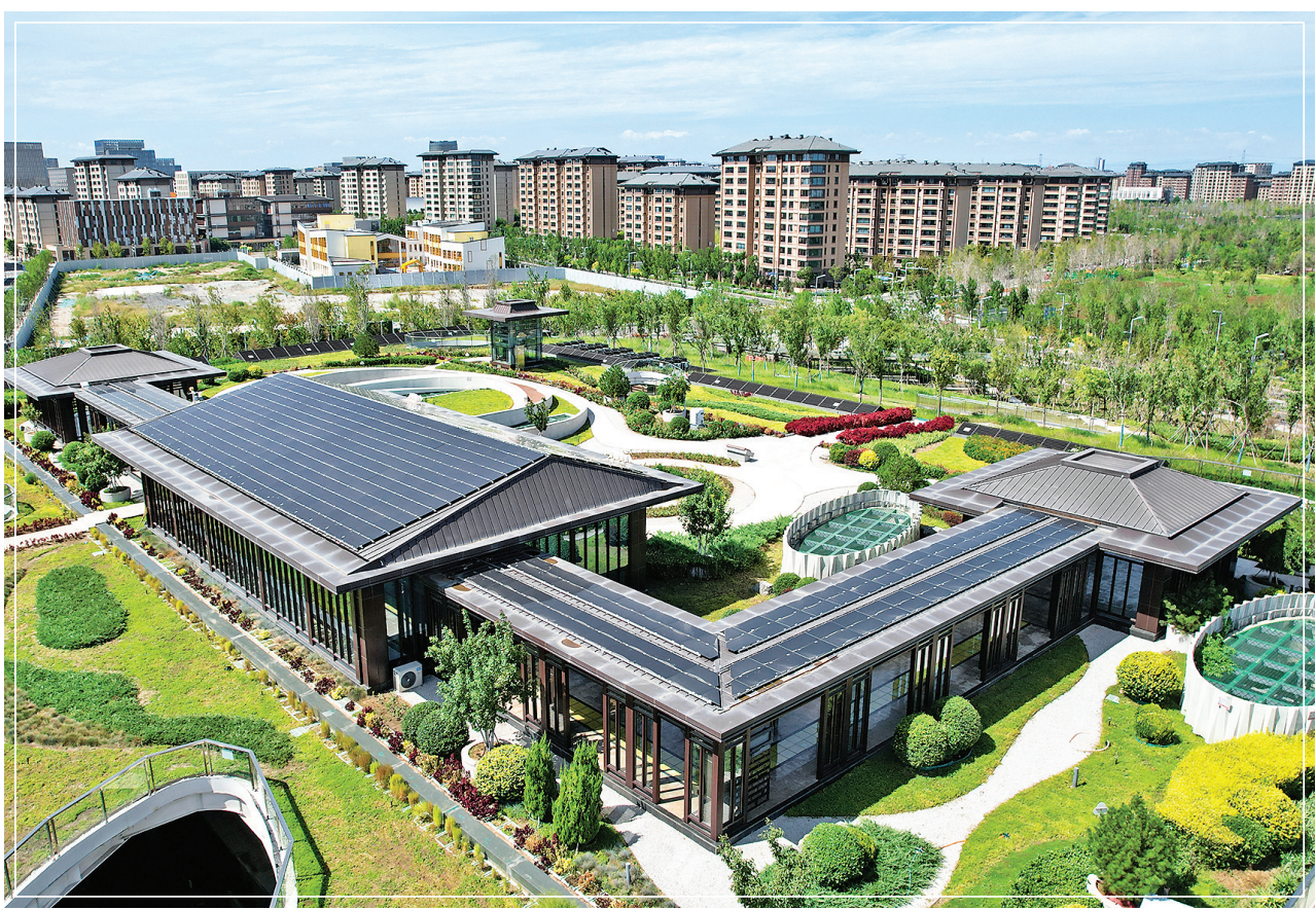
9月5日拍摄的河北雄安新区“智慧能源立方”——剧村220千伏变电站外景。该变电站屋顶覆土建设成公园,形成与城市融合共生的图景(无人机照片)。
