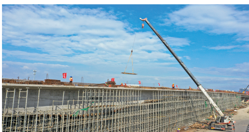
9月19日,施工人员在盐湖高新区西外环道路改造工程现场加紧施工。该项目是我市“盐临夏”一体化发展重点项目,总投资3.03亿元,目前正在进行桥梁、通道和路基施工,预计明年5月竣工通车。本报记者 闫鑫 摄
