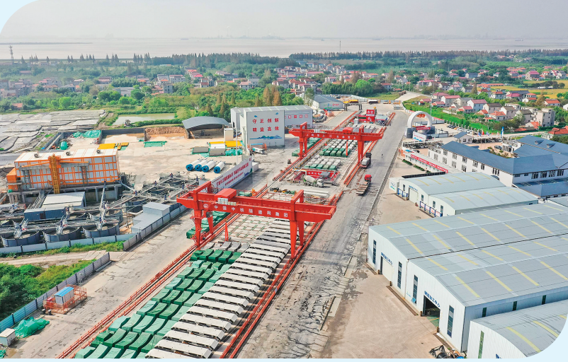
10月20日在上海拍摄的崇太长江隧道项目3号井(无人照照片)。
