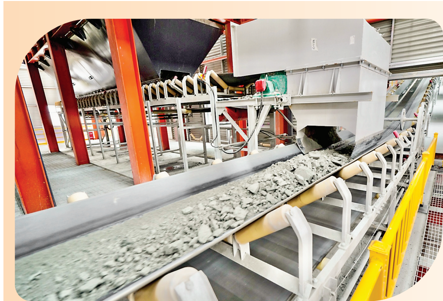
▲垣曲县园子沟尾矿库智能输送工程。
